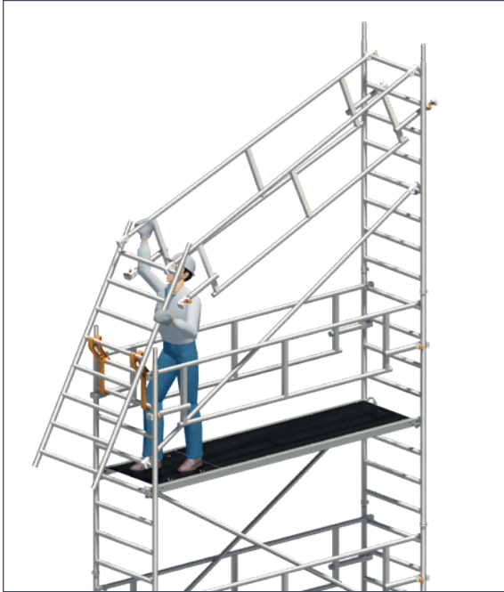
1 Aufstecken der ersten Standleiter. Anbringen der Uni Montagehaken und Positionierung der zweiten Standleiter zur Montage des Doppelgeländers auf beiden Seiten.
