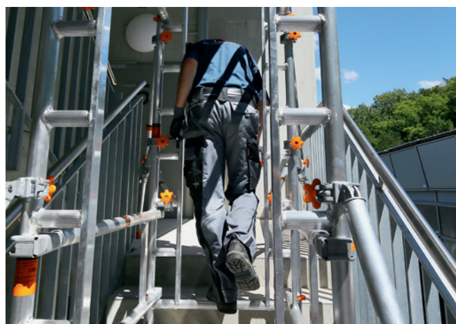
Einsatz SoloTower mit Treppen-Kit – baustellentaugliche Durchgangswege
